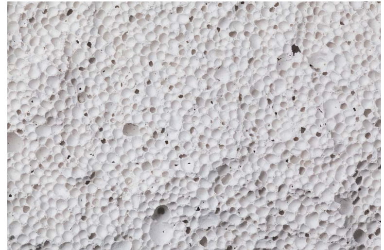
Ampliación estructura bloque de hormigón ligero u hormigón celular
