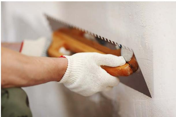
Extender el mortero con la llana dejando un espesor medio de 8-10 mm, dependiendo del acabado deseado o posterior. Pueden aplicarse espesores de hasta 20-25 mm, en capas sucesivas de 10 mm de espesor por día. Reglear el material aplicado para regular el espesor y alisar la superficie.
