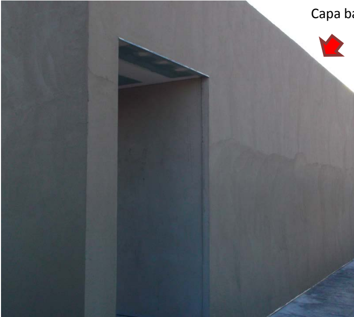
Aplicación de Pétrex 5 Mortero Acrílico Fino en color Blanco (previa imprimación con Pétrex 5 Liso Blanco ). Encuentro del SATE con fachada ventilada.
