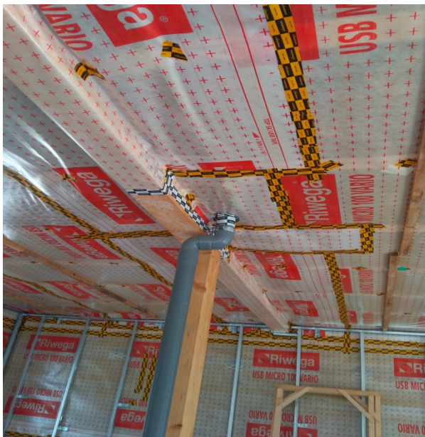
Barrera de vapor y encintado interior
